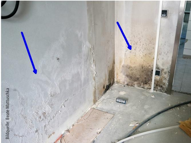
Abb. 2: Technikraum, Feuchteschäden an der Massivwand und Schimmelbefall an der Leichtbauwand
