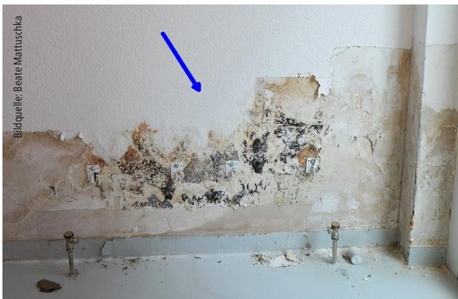
Abb. 4: Treppenhaus mit Feuchteschäden
