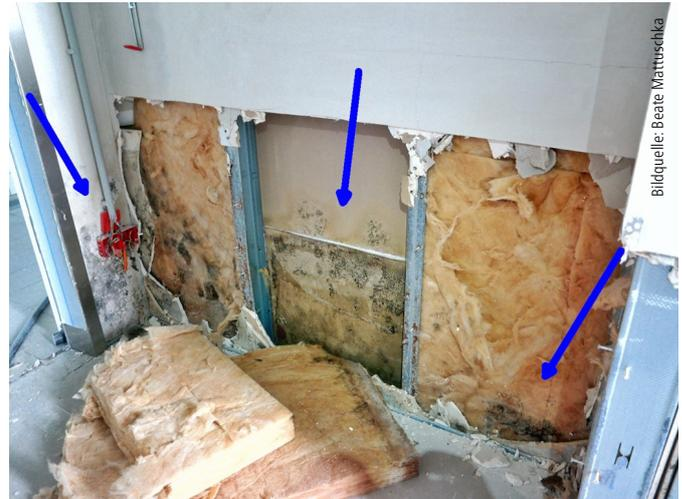
Abb. 3: Technikraum, geöffnete Leichtbauwand mit sichtbaren Schimmelschäden
